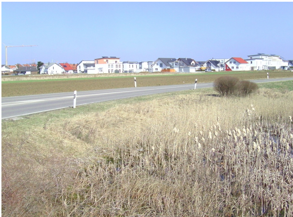
Abbildung 7: Künstlich angelegte naturnahe Versickerungsmulde an der Walpertshofer Straße bzw. der Kreisstraße K 7518 (MAIER 2012)
